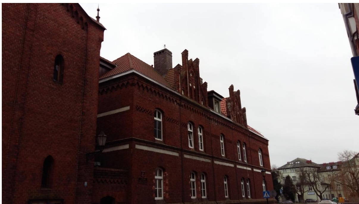
62) Zespół budynków dawnego ewangelickiego klasztoru Diakonis.
